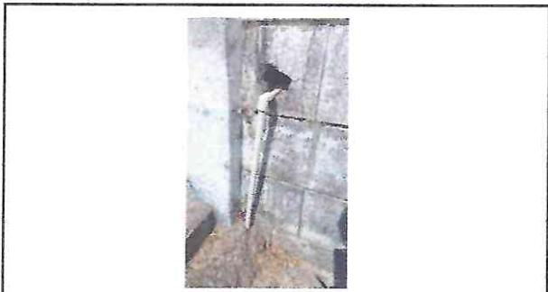
Foto 9: sustitución de llave de paso
