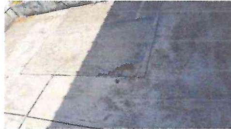
Foto 16: reparación de planchas de concreto
