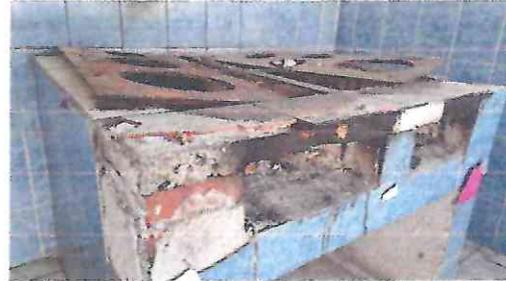
Foto 20: sustitución de plancha de metal de 3 hornillas
