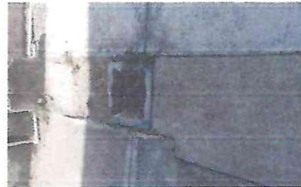
Foto 6: reparación de cuneta de concreto
