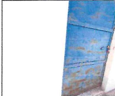
Foto 1: mantenimiento puertas de metal ( lijado, cambio de tubo, cepillado, sujeciones, aplicación de pintura)
