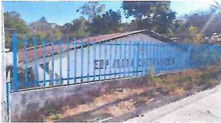
Foto 15: reparación de muro perimetral de block con tuvo hg y malla galvanizada, solares intermedias y columnas.
